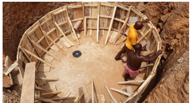
Verschalen des Biogas-Doms
