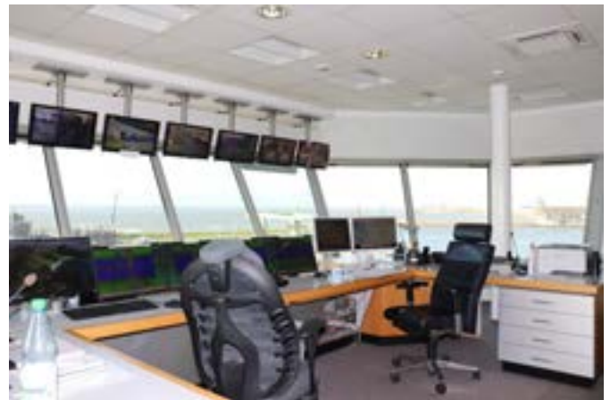
Alles im Blick: Der Schleusenaufseher der Kaiserschleuse steuert von seinem Arbeitsplatz aus noch weitere Schleusen und Hafeneinrichtungen
