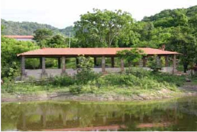
(Der Speisesaal kurz vor der Fertigstellung)
