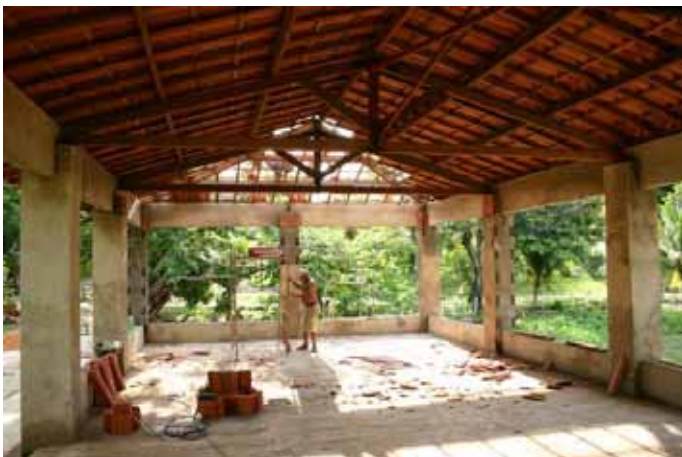
(...die Fliesen müssen noch gelegt werden)
