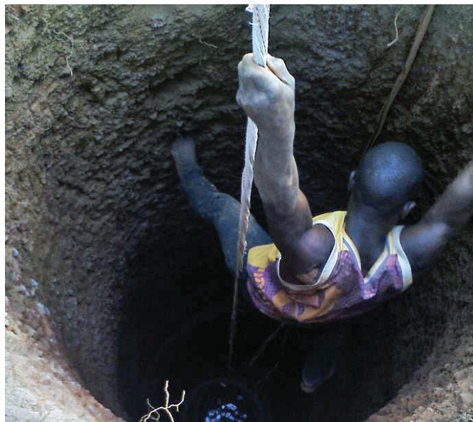
Abenteuerliches Arbeiten im Brunnen in Wondikhoure, Guinea: In 14 m Tiefe wird der Sauerstoff knapp (Foto: KANIA e. V.)
