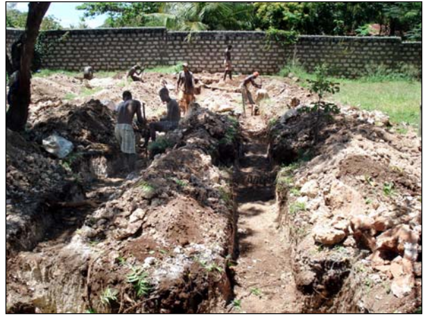
Die ersten Arbeiten für das neue KiD-Schulgebäude.
