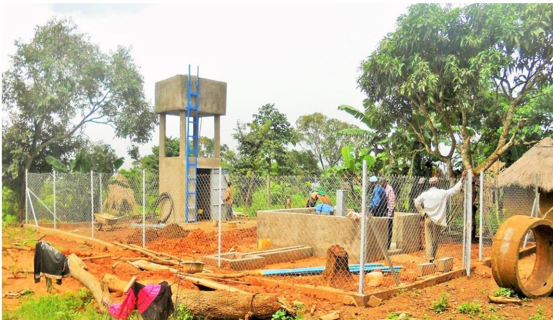
**Das Klein Wasserwerk in Wondikhore.** Von hier wird das Wasser zur Schule. Auch von hier sollen alle Einwohner in Wondikhore das Wasser bekommen werden. Das Ziel ist, in der Zukunft werden die Wasserleitungen von das Wasserstelle bis zur letzter Haus gelegt. Das Gelände ist mit einem Schutzgitter ausgerichtet. Es gibt nur einem schließbar Metall Tür für der Eingang. Unter den Wassertank ist ein Lager für den Stromgenerator und andere Geräte gebaut worden. Das Lager hat auch einen Metalltür.
