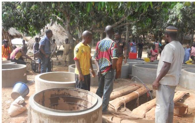
Die Herstellung von die Betonrohren geht auch parallel zu den Brunnenbau weiter.
