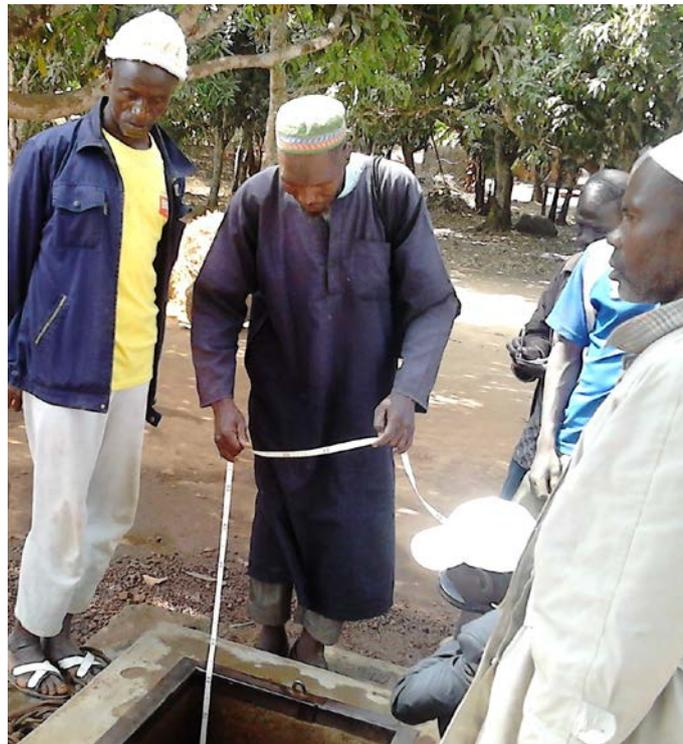
Der aktuelle Brunnen ist zurzeit: durchmessen 80 cm, Tiefe 10 m. Wasserspiegel (Niveau d'eau statistique est 8,7 m). Der Brunnen soll weiter ausgebaut werden, und zwar bis 20 m Tiefe soll gebohrt werden. Das Innere des Brunnens wird betoniert. Evtl. Einem Wasserbehälter wird mit gebaut. Das Ziel, die Schule soll das Wasser vor der Schule
