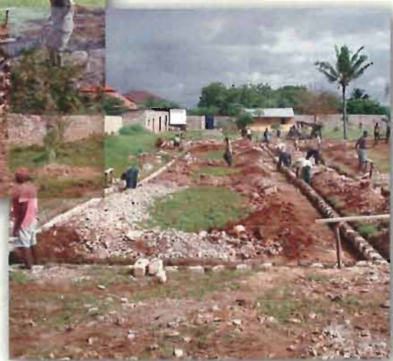
...denn die Grundmauern sind schon zu erkennen.
